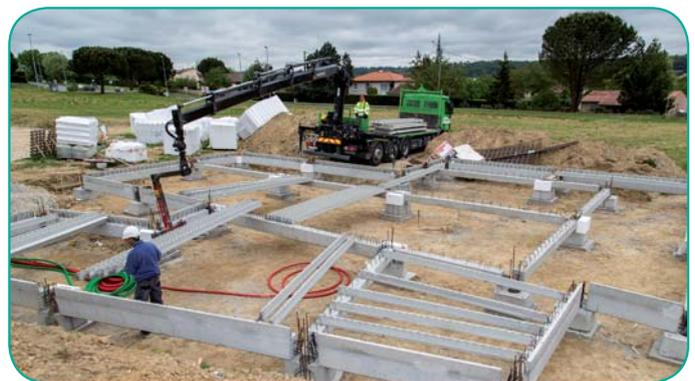
► Utilisation possible de cales en béton pour régler l'altimétrie sous les longrines.
