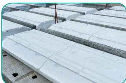
Psi, ou coefficient de pont thermique linéique, est une grandeur permettant de quantifier les déperditions de chaleur à la jonction mur/plancher d'un bâtiment. Pour limiter ces déperditions en isolation par l'intérieur, il y a donc lieu de placer des rupteurs de ponts thermiques.
