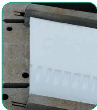
**La réalisation d'un biais :** la découpe de l'entrevous sera effectuée en biais afin d'obtenir un appui de 3 cm contre le mur. Il suffit de fixer les rupteurs sur la partie supérieure de l'entrevous afin de respecter la continuité du doublage des murs.
