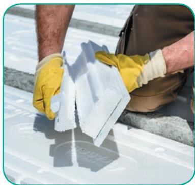
**Le traitement du faux entraxe :** fini les côtes de départ imposées en fonction du type de rupteur. Grâce au rupteur de rive sécable, vous avez la possibilité de gérer le faux entraxe sur la dernière travée.
