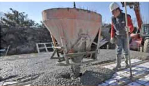
► Le béton est déversé sur les appuis, puis réparti de façon uniforme vers le centre des travées en évitant les masses de béton ponctuelles.
