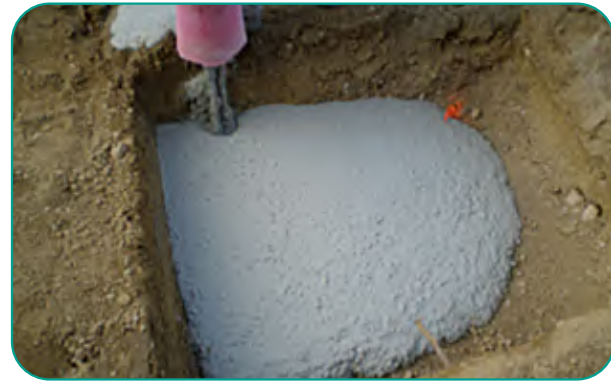
► Coulage du béton de propreté.
