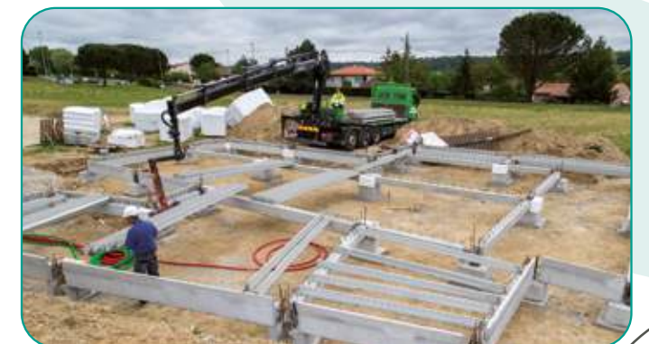
► Utilisation possible de cales en béton pour régler l'altimétrie sous les longrines.
