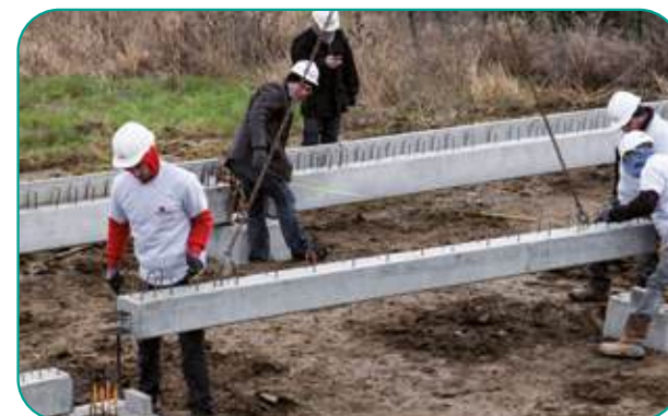
► Utilisation possible de cales en béton pour régler l'altimétrie sous les longrines.
