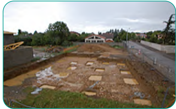
► Terrassement de la plateforme et des massifs.
