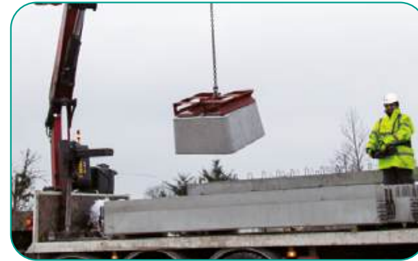
► Assemblage des semelles et plots sur le camion pour optimiser le nombre de grutages.
