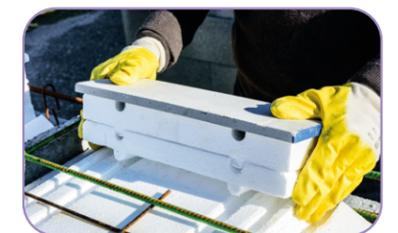
**Avec la solution Neoset Feu** veiller à clipser la rehausse sur l'entrevous puis fixer le rupteur de rive ou d'about dessus.
