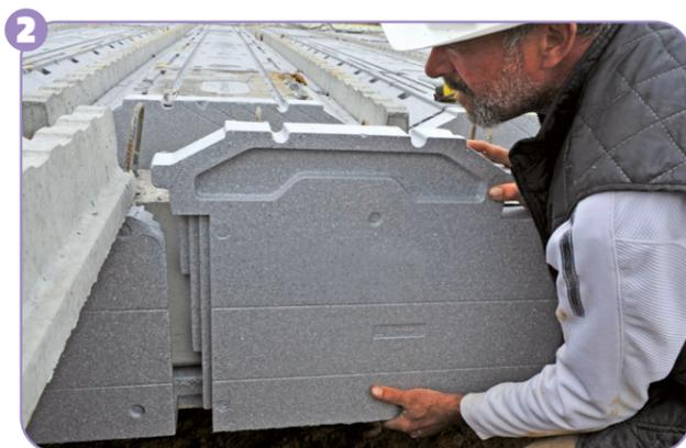
2 Le Fabrifend sert également de rupteur pour traiter la poutre PSR.
