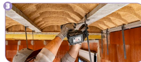
Fixation du pivot de la suspente.
