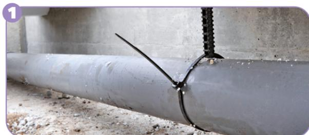
Grâce à la suspente de canalisation, la pose des canalisations est soignée et pérenne.
