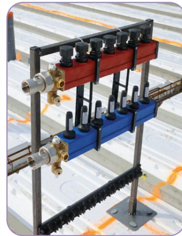
Fixer le RailFix sur la traverse basse du support à l'aide de Rilsan. Fixer les collecteurs sur les 2 traverses hautes à l'aide de Rilsan.
