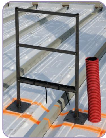
Emboîter le support sur les platines. Fixer les platines à l'aide de pointes d'ancrage sur l'entrevous ou les ligaturer au treillis soudé.
