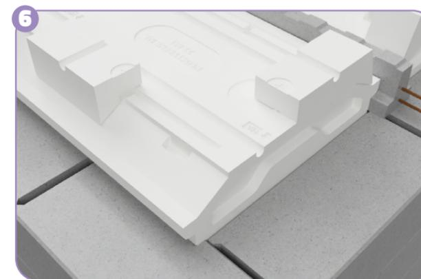
**DANS L'ANGLE :** disposer les rupteurs en fonction de la zone sismique. En zone 3 et 4, découper en deux les rupteurs.
