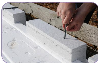
**Avec la solution Neoset Essentiel** les rehausse s'installent simplement au-dessus des rupteurs de rive et d'about.
