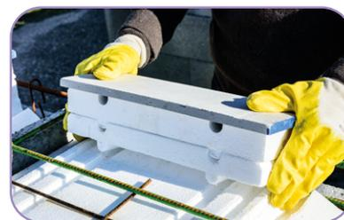
**Avec la solution Neoset Feu** veiller à clipser la rehausse sur l'entrevous puis fixer le rupteur de rive ou d'about dessus.
