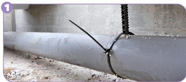
Grâce à la suspenste de canalisation, la pose des canalisations est soignée et pérenne.
