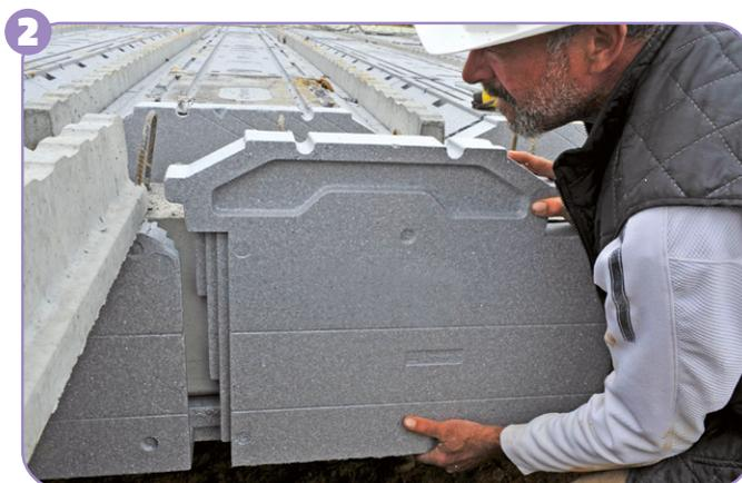
2 Le Fabrifend sert également de rupteur pour traiter la poutre PSR.
