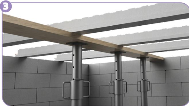
**POSE DES ÉTAIS** (selon dispositions du plan de pose). L'étalement doit être au contact de la poutrelle.
