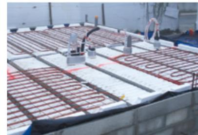
Quelle que soit votre solution Neo Chauffant / Rafraichissant, le kit rehausse rupteurs, permet de s'adapter à la hauteur coffrante du plancher tout en conservant une excellente performance thermique.
