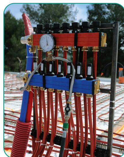
Clipser les tubes sur le RailFix et les raccorder aux collecteurs.
