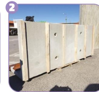
Le support en bois traité autoclave permettant de recevoir le bardage est solidement ancré dans le béton au moment du coulage.
