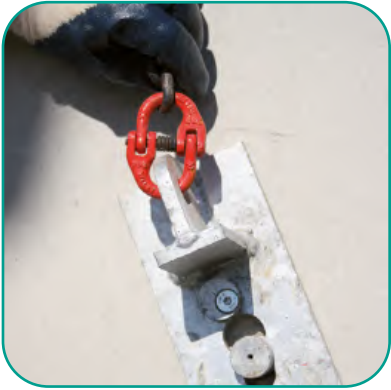
2 ème étape Verrouiller la partie femelle sur la partie mâle, au dos du mur.
